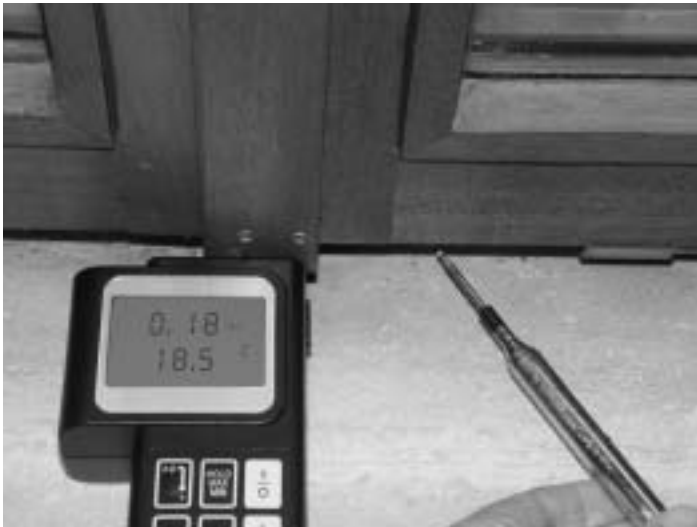
Abb.24: Messung an einer Fensterfuge
