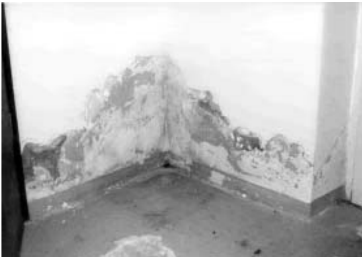
Abb. 25: Feuchteschaden-Beispiel
