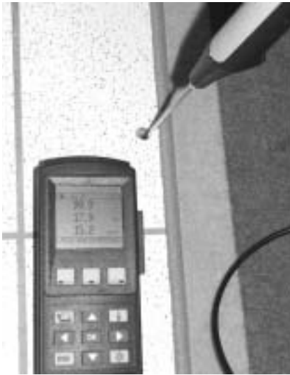
Abb. 20: Messung in Probebohrung eines Fliesenbodens
